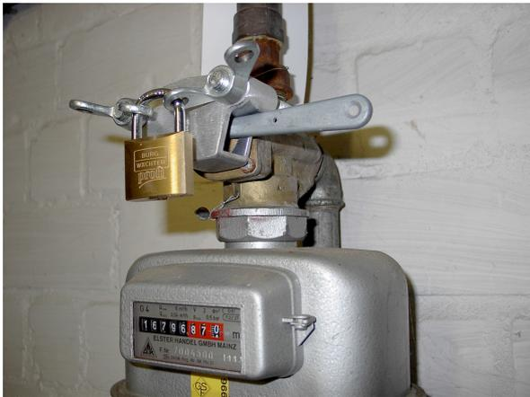
**Sicherung montiert an einem Einrohrzählerhahn**
